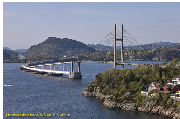
Bilde 10: Nordhordalandsbrua, kombinasjon av hengebru og flytebru.
