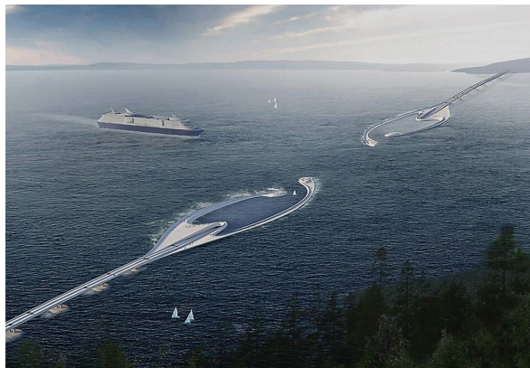
Bilde 9: Prosjekt bilde av kryssing av trondheimsfjorden med flytebru og rørtunnel.
