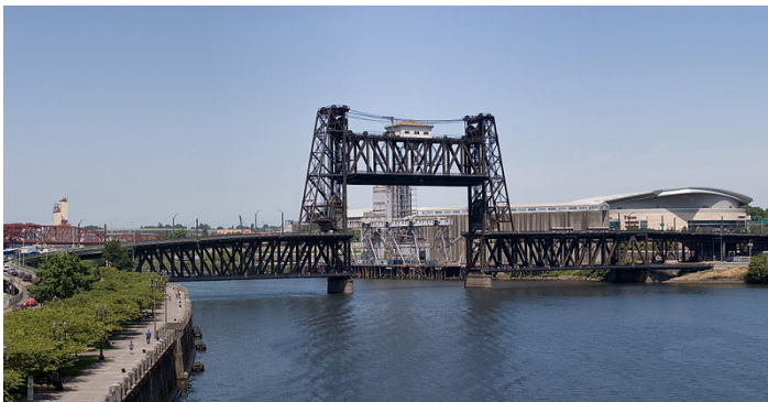
Bilde 6: Steel Bridge i portland er en hevebri.
