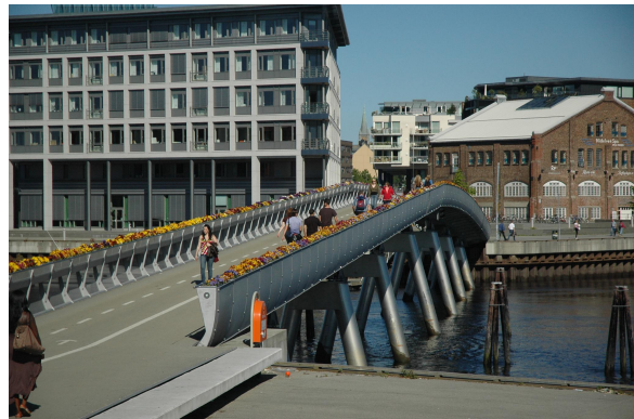
Bilde 5: Verftsbrua fra midtbyen over til solsiden er en rullebri. Brudekket ruller tilbake under dekket på midtbyen.
