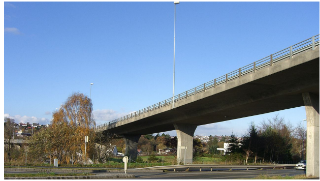
Bilde 3: Bjelkebru over vei.
