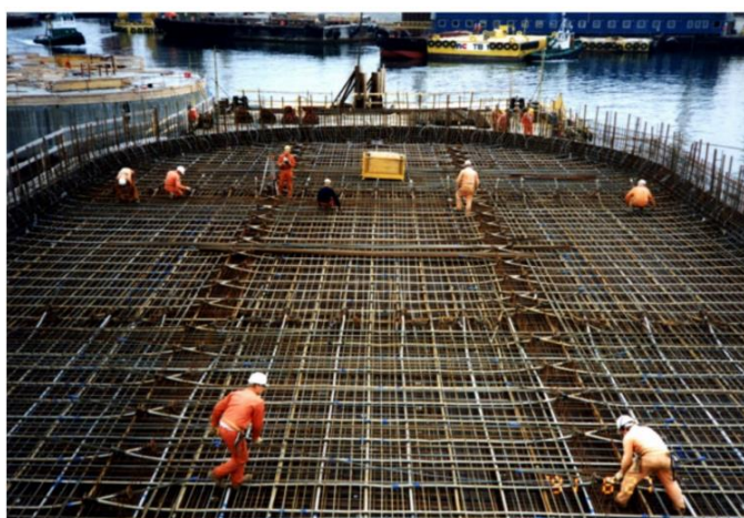
Figur 24: Konstruksjon av pontonger (2)
