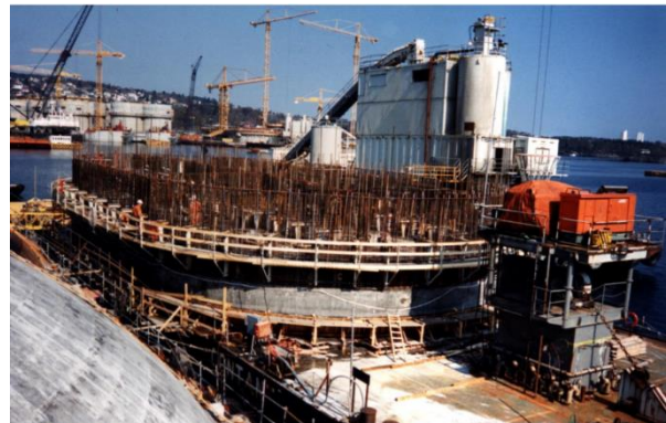
Figur 22: Pontong under konstruksjon (2)
