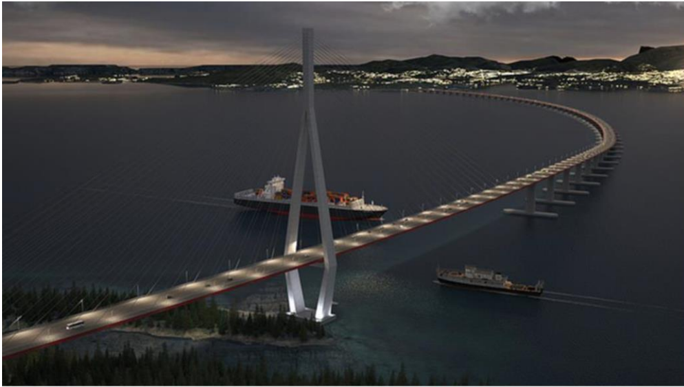
Illustrasjon av mulig endeforankra firefelts flytebru for E39 over Bjørnafjorden sør for Bergen
