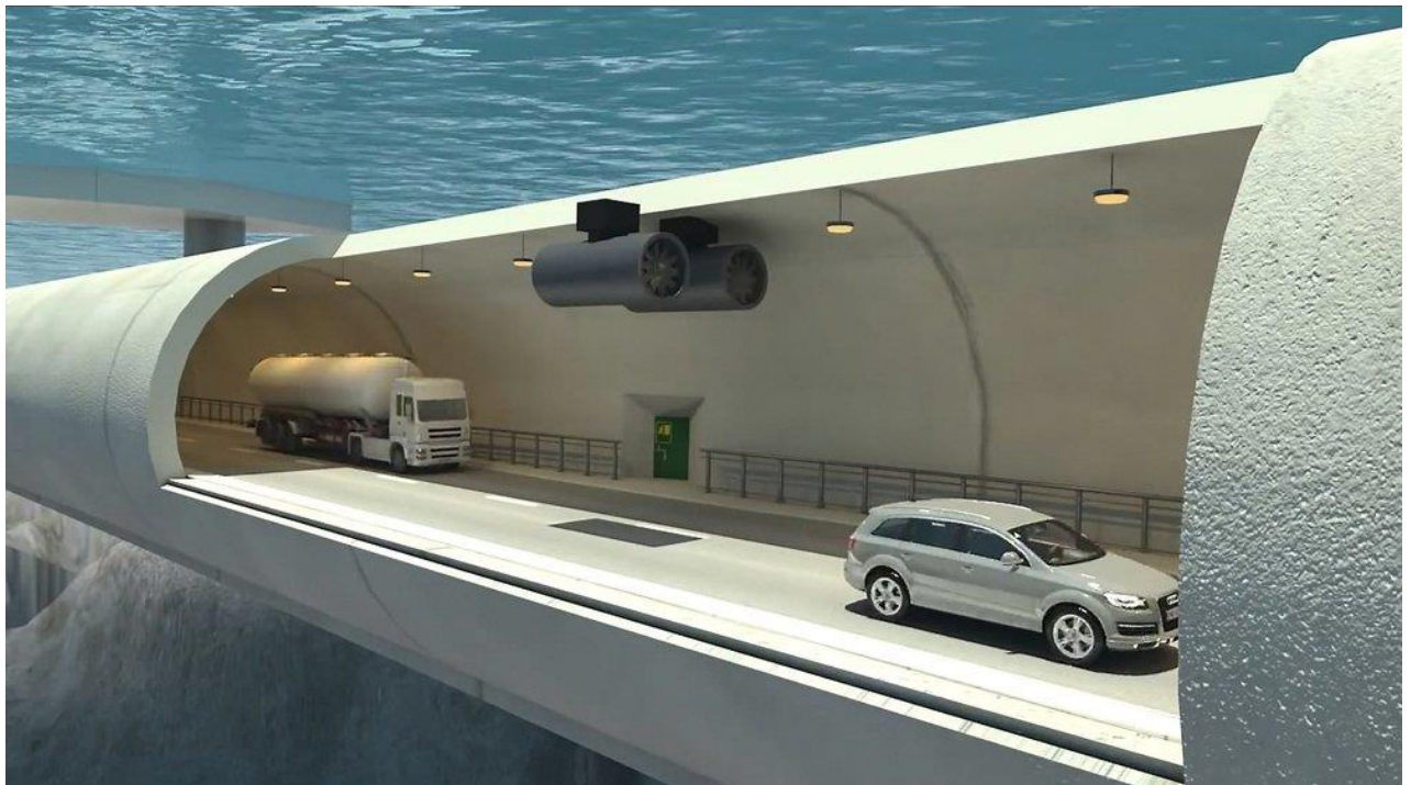
Figur 4.3 Prinsipp neddykket rørbru
