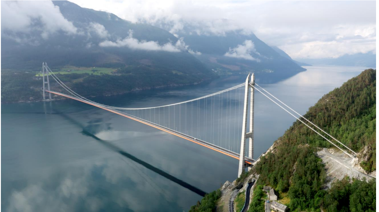
Figur 10 Hardangerbrua – Hovedspenn 1310 meter. Norges lengste hengebru
